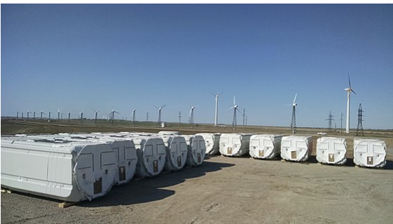
Гондоли Nordex на стадії будівництва на фоні існуючих турбін USW56-100. 2020 рік.
