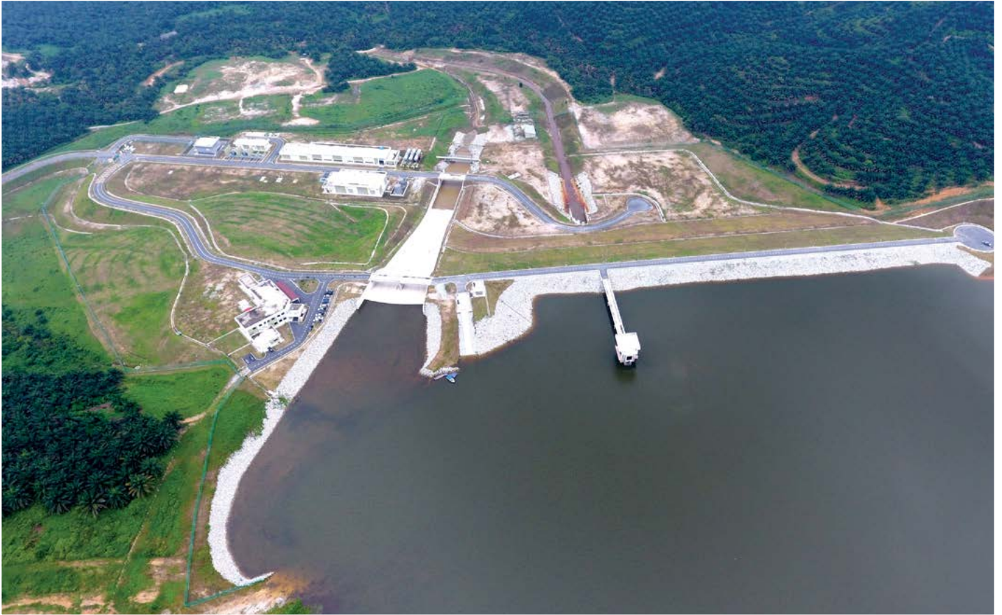
Seluyut Dam in Kota Tinggi, Johor
