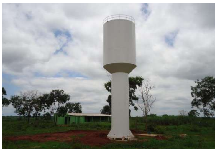
Figura 17: Perfuração do poço e instalação de reservatório de 30 mil litros. Assentamento 20 de Março, Três Lagoas/MS Fonte: FIBRIA, Relatório Destaques MS 2015.
