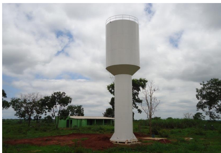
Figura 17: Perfuração do poço e instalação de reservatório de 30 mil litros. Assentamento 20 de Março, Três Lagoas/MS Fonte: FIBRIA, Relatório Destaques MS 2015.
