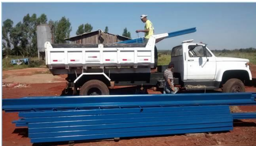
Figura 18: Construção do Centro Comunitário do Assentamento São Joaquim, em Selvíria/MS
