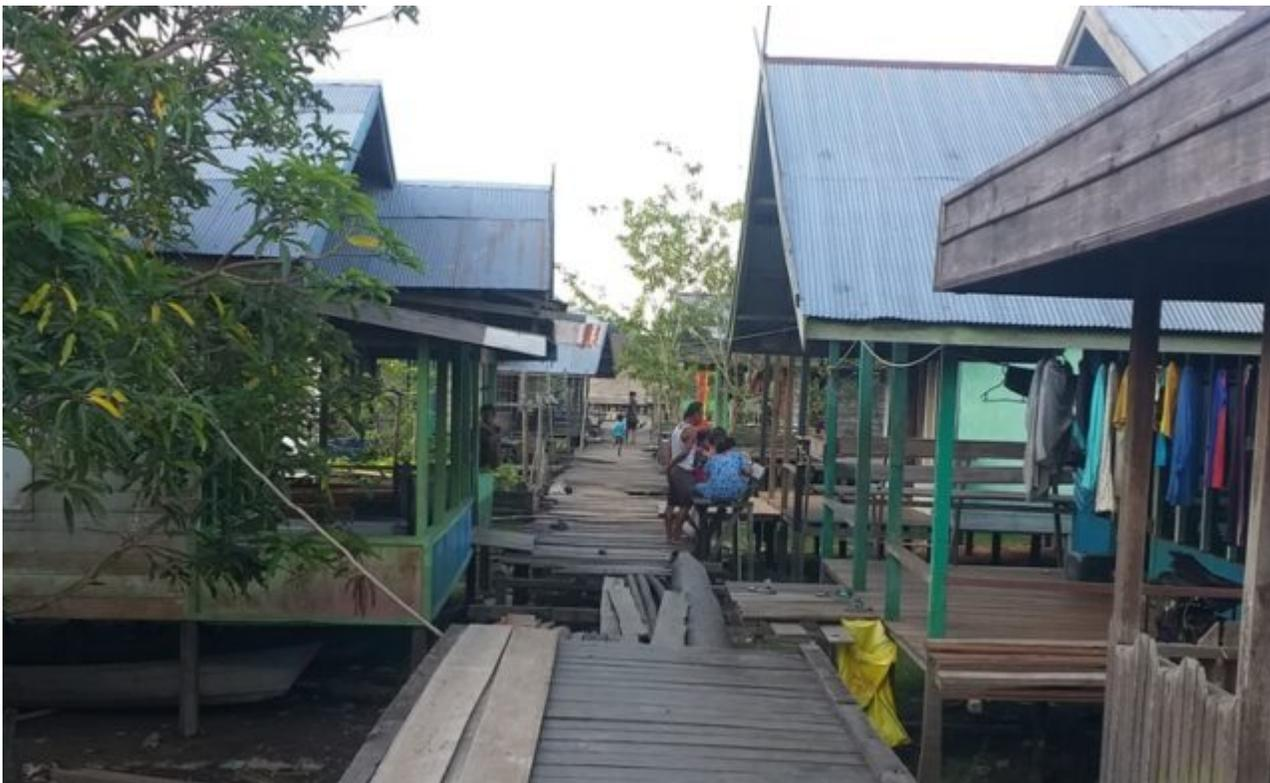
*Foto: Jalan titian dari kayu ulin yang ada dipinggir sungai dusun Muara Ubar tampak rusak parah.*
