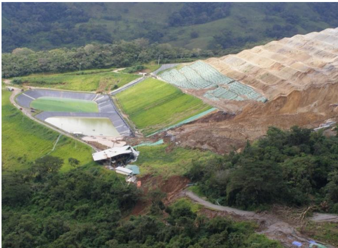
Colapso de la pila de lixiviación de cianuro en Bellavista. Crédito: Sonia Torres, CEUS del Golfo
