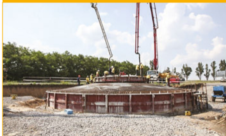
Рис. 3. Монтаж Лутугинської ВЕС 16
