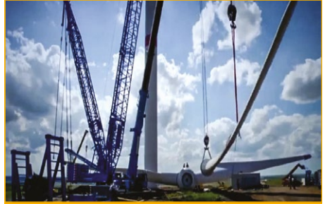
Рис. 20, 21. Розміщення крану та складування будматеріалів і складових конструкцій ВЕС на ділянці поряд із ділянкою відводу (Краснодонська ВЕС)
