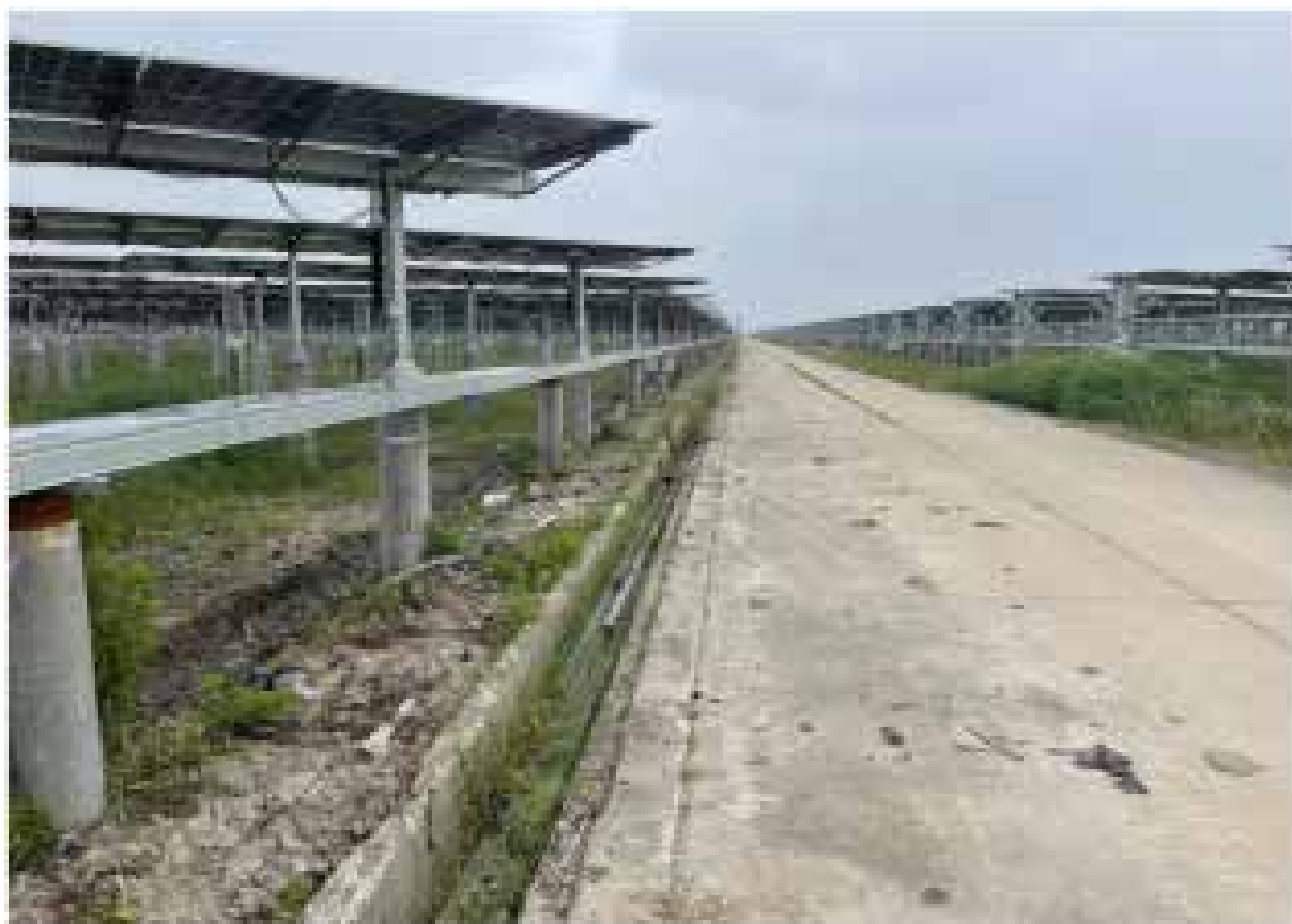
图 13 道路两侧排水沟
