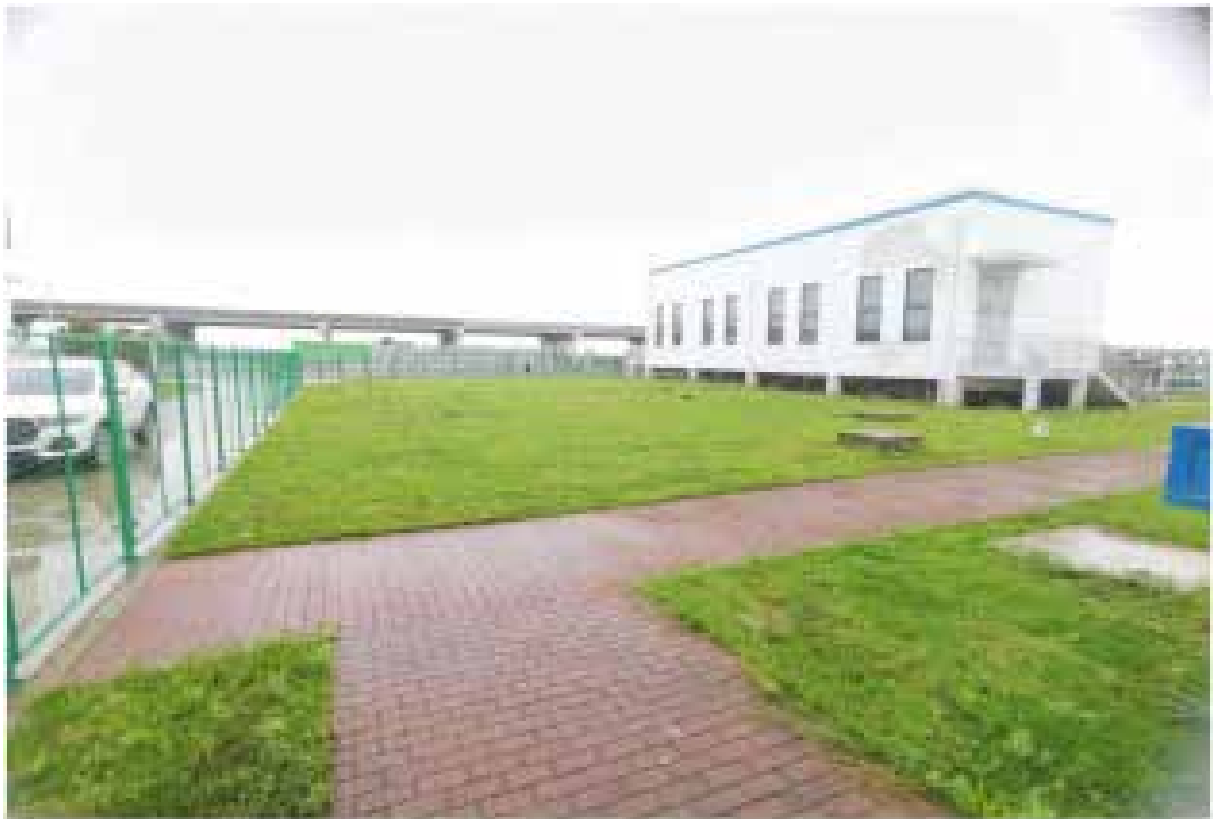
图 16 升压站内绿化
