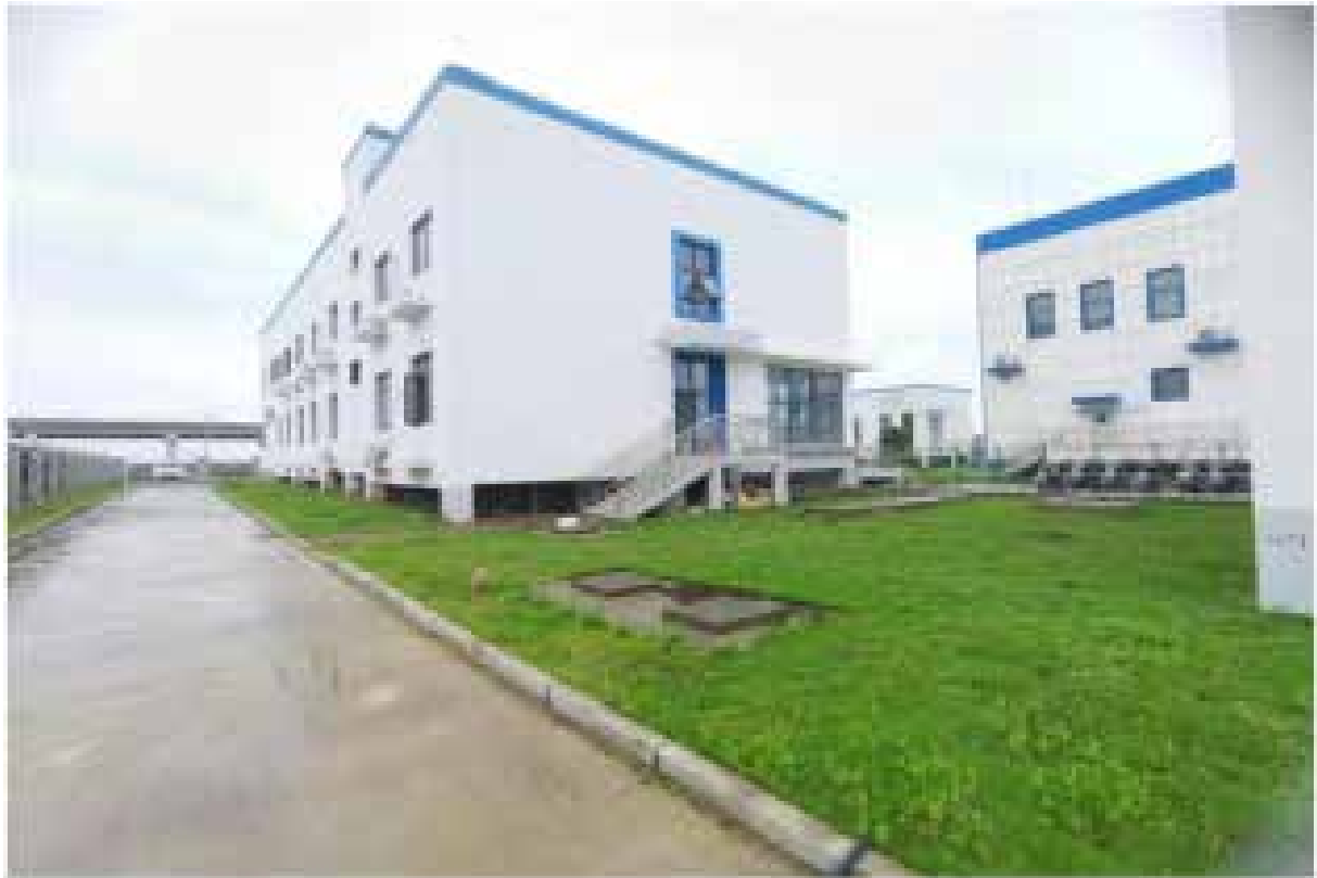
图 18 升压站内绿化
