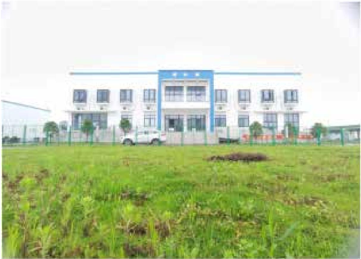
图 15 升压站内绿化
