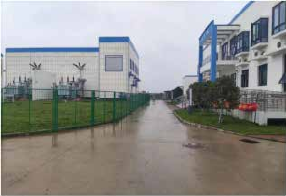
图 17 升压站内绿化
