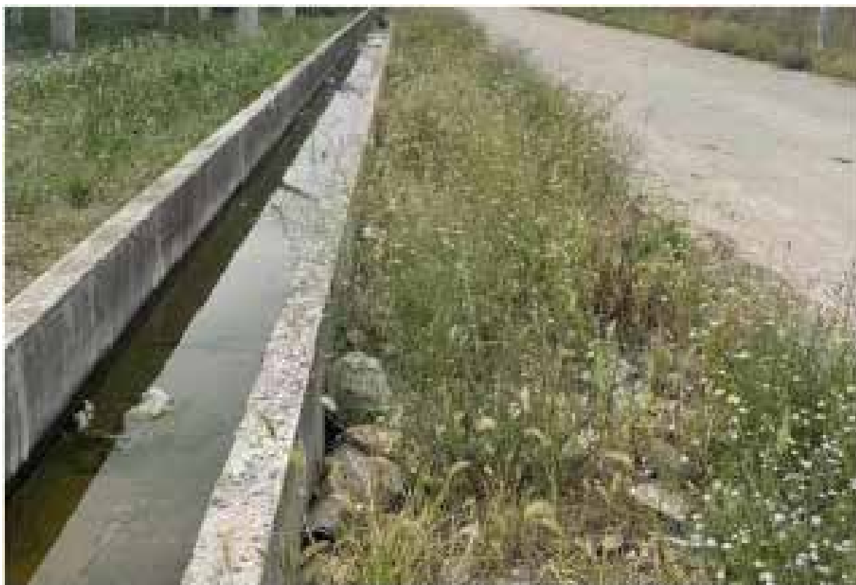
图 12 道路两侧排水沟
