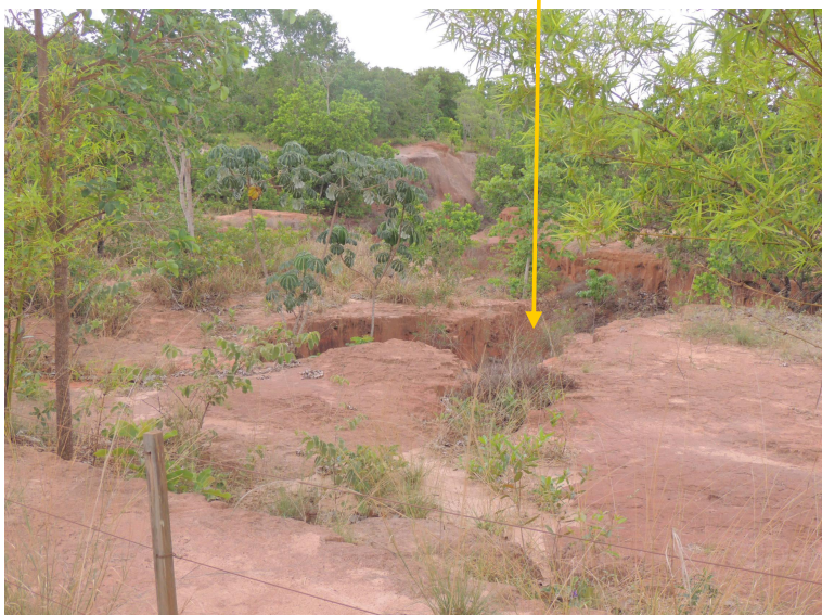
Foto da área na estrada MS 444 onde há grandes rachaduras no chão. Coordenadas -20°10'52, -51°47'22.
