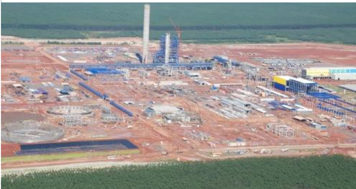
Figura 3 - Construção da International Paper em Três Lagoas-MS, em 2007.
