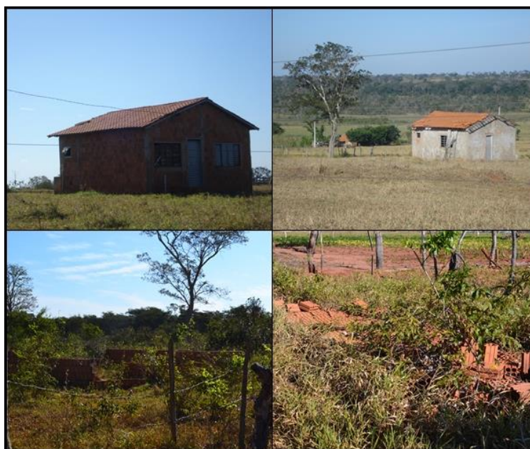
Figura 19 – Paulistinha/Três Lagoas (MS): casas e materiais para construção abandonados
