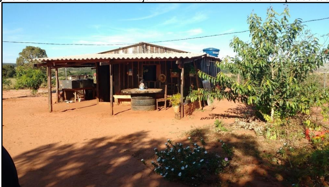
Figura 45 – Ribas do Rio Pardo: Projeto Novo Modelo II – autoconstrução de casa
