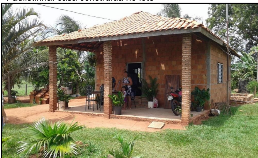
Figura 21 – Paulistinha: casa construída no lote
