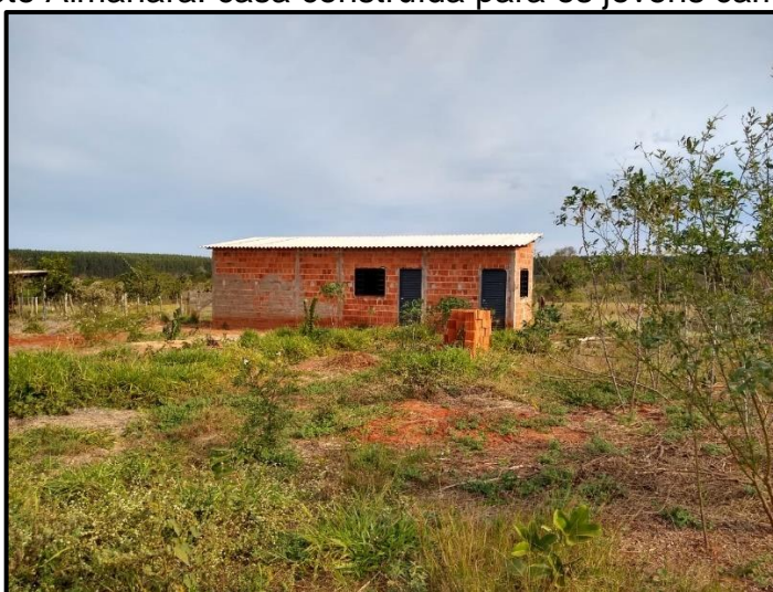
Figura 35 – Projeto Almanara: casa construída para os jovens camponeses
