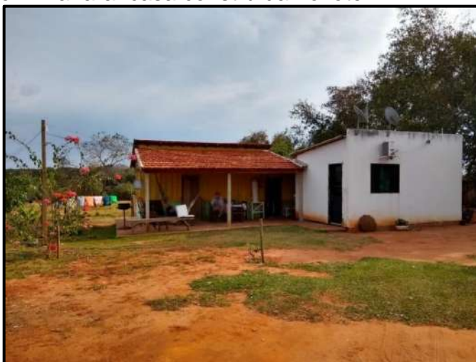
Figura 34 – Projeto Almanara: casa construída no lote
