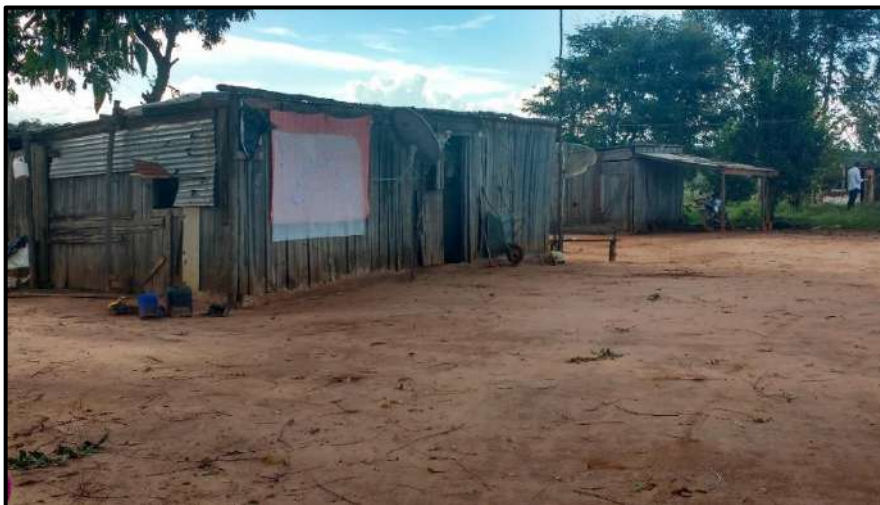
Figura 43 – Ribas do Rio Pardo: Projeto Nossa Senhora das Graças – casa autoconstruída
